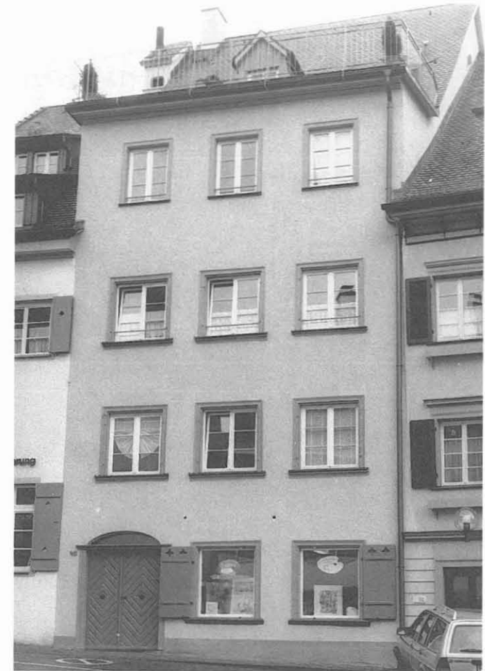
Marktstraße 40 Eigentümer: Dr. E. Leopold Dieck Das fachkundig sanierte Gebäude birgt im Inneren einen Schatz, einen ehemaligen „Wohnturm“ aus der Zeit vor dem 13. Jh.
