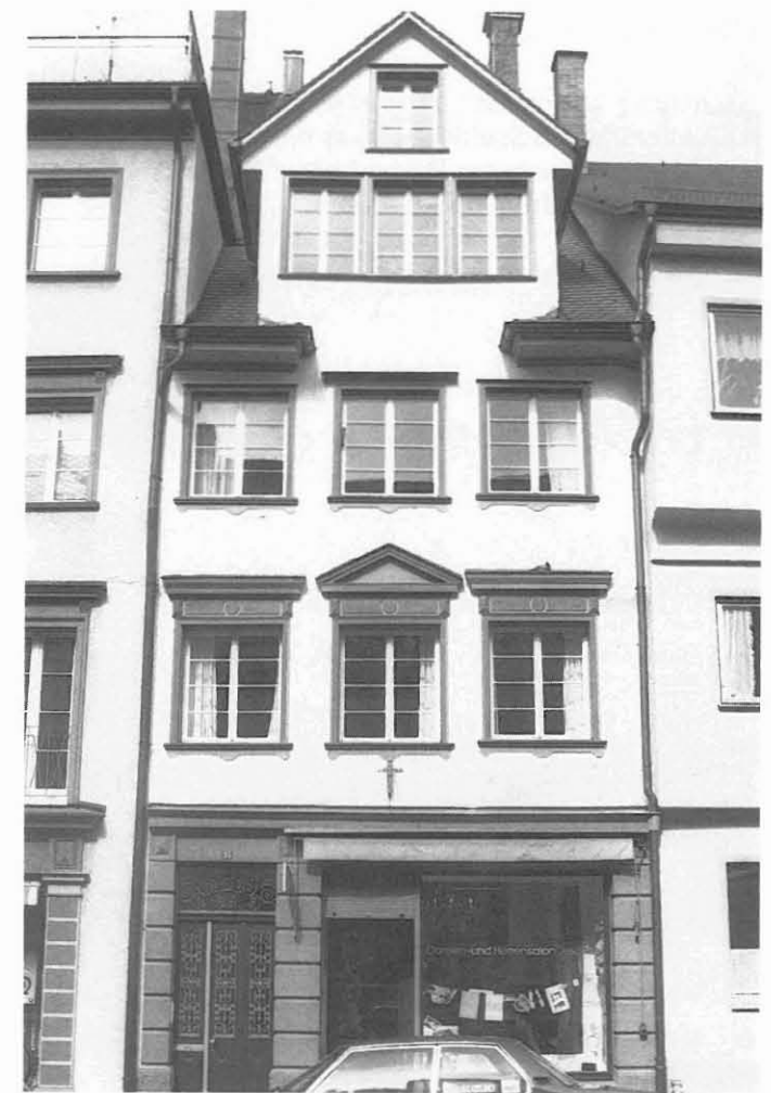
Herrenstraße 35 Eigentümer: Thomas Weiss Vom Scheitel bis zur Sohle eine gelungene Renovierung.
