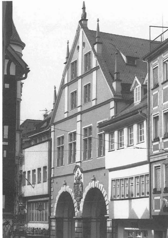
Marktstraße 13 „Altes Theater“ · Eigentümer: Stadt Ravensburg Der vorbildlich renovierte Ausstellungssaal ist durch das Treppenhaus im Gebäude Marktstraße 15 neu erschlossen. Die Renaissancefassaden sind sorgfältig instandgesetzt.
