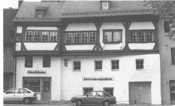
Roßbachstraße 6 · Eigentümer: Erich Lange Eine außergewöhnliche Sanierung, außen wie innen. Hier gibt es noch den traditionellen Handwerksbetrieb mitten in der Altstadt.
