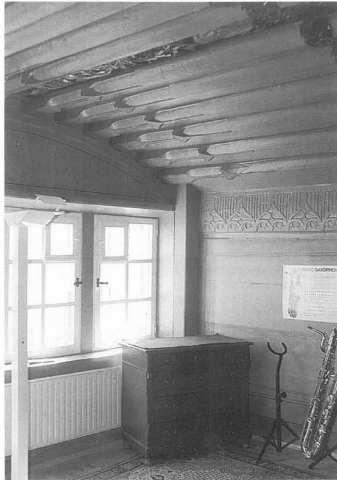
Die nur 4 x 5 m messende Stube im Hinterhaus Roßbachstraße 6 mit einer spätgotischen Decke und Kerbschnittbändern an der Tüferwand.
