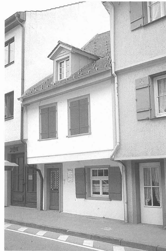
Obere Breite Straße 44 Eigentümer: Frieder Wurm Eines der kleinsten Häuser in der Unterstadt im ursprünglichen Glanz.
