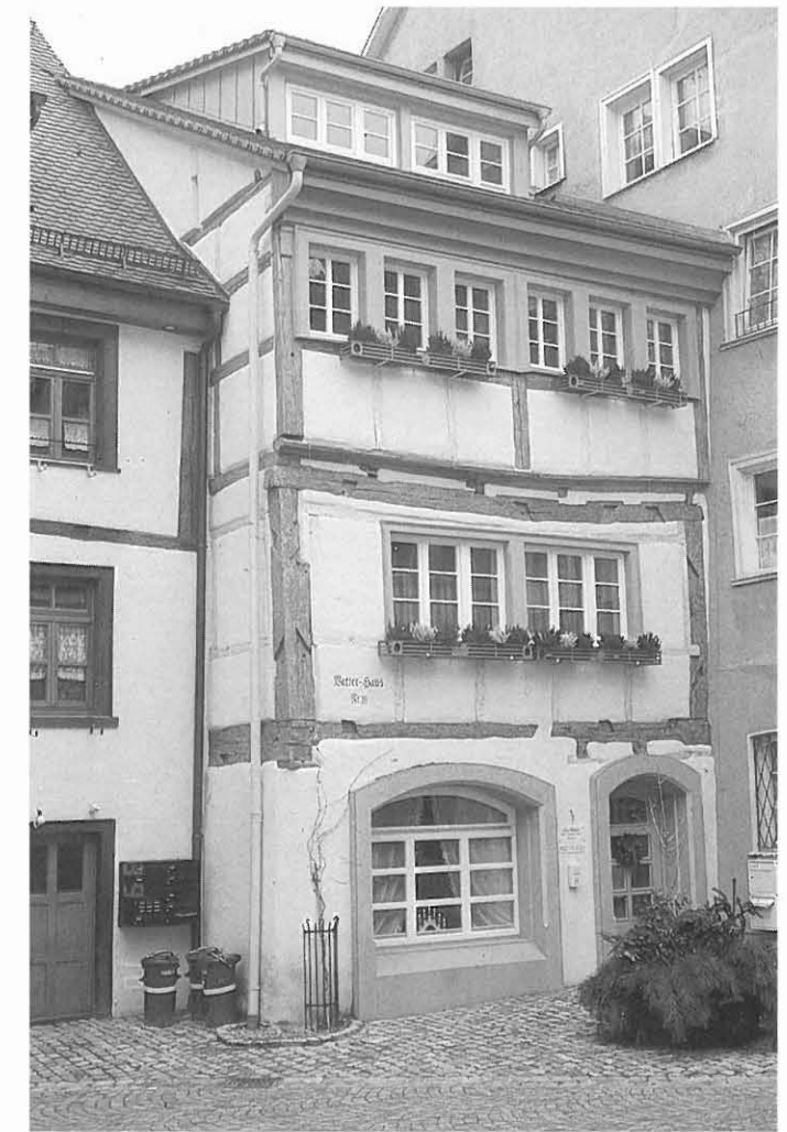
Schulgasse 16, sogenanntes „Vetter-Haus“ Eigentümer: Familie Bulay Sorgfältige, aber auch eigenwillige Renovierung der noch vorhandenen Fachwerkkonstruktion.
