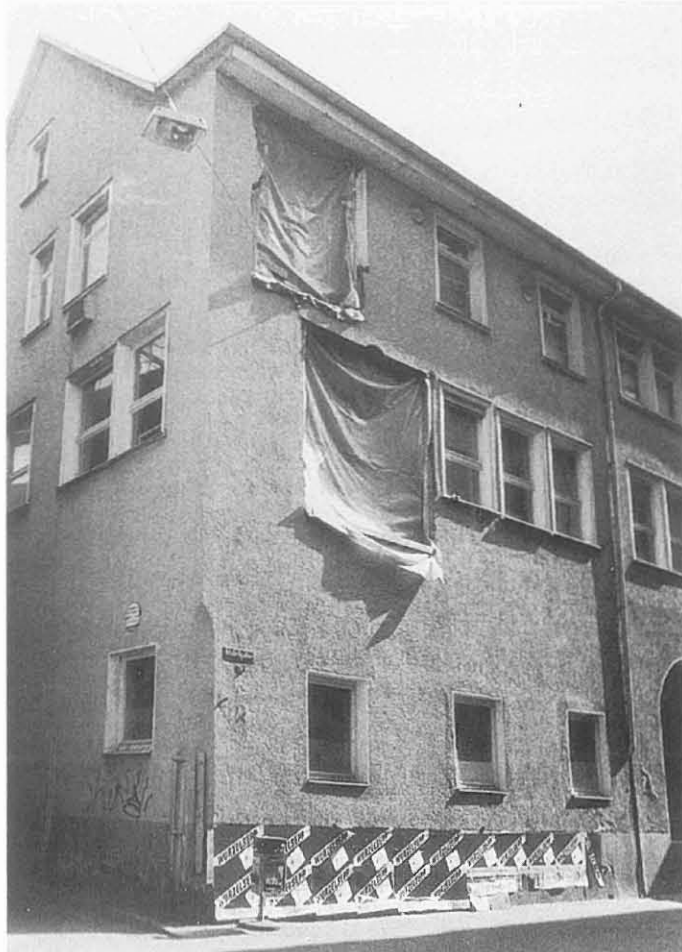
Stadelgasse 1 – das mittelalterliche Badhaus mit einer Badeanlage im Keller und im Erdgeschoß.
