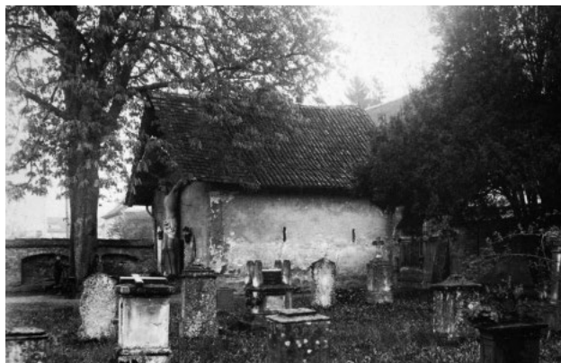
Oben: Die alte Ummauerung von Südwesten. Unten: Blick in den alten Friedhof mit Beinhaus Historische Aufnahmen, Stadtarchiv Ravensburg
