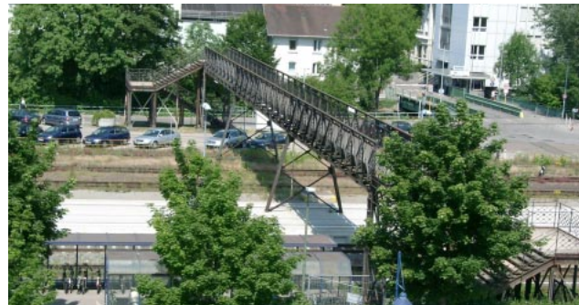
Eschersteg 2006 kurz vor dem Abbruch (Quelle: Volker Petzold)
